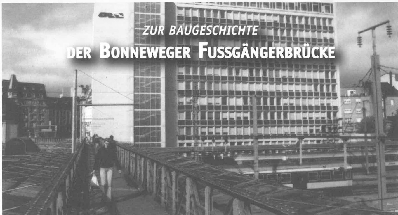
Fußgängerüberführung zur Seite der Gleisanlagen anno 2003.
